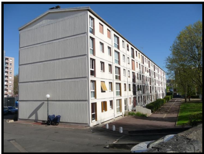
Un des trois bâtiments de la copropriété.
